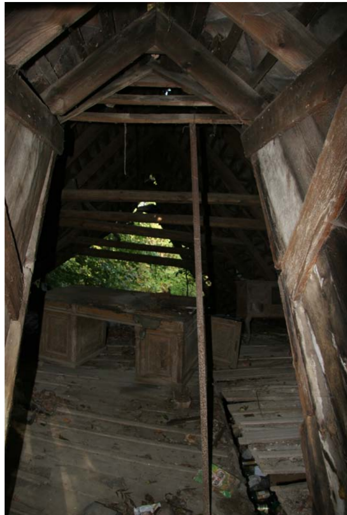
Az épület padlása
