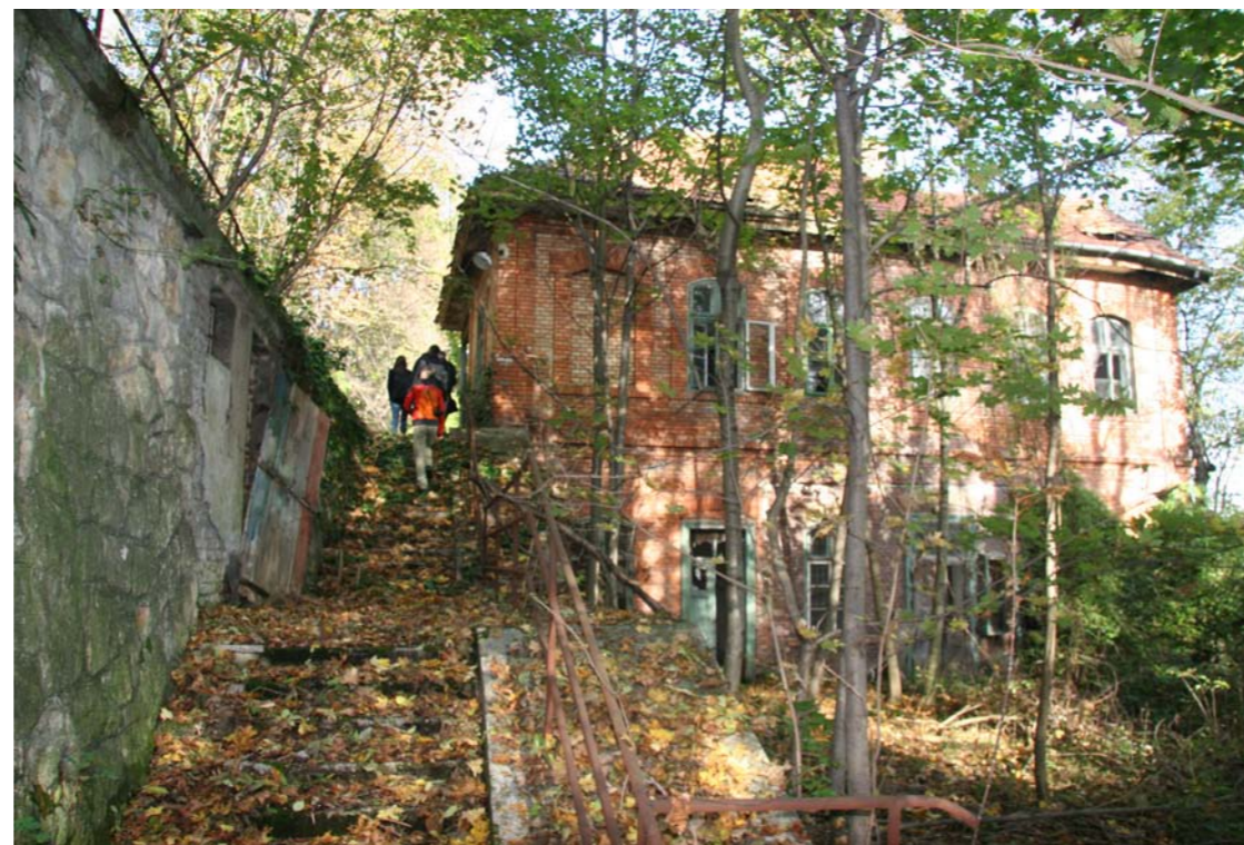
Az üdülőépület jelenlegi állapota
