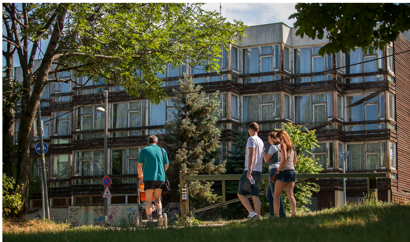
Az épület jelenlegi állapota
