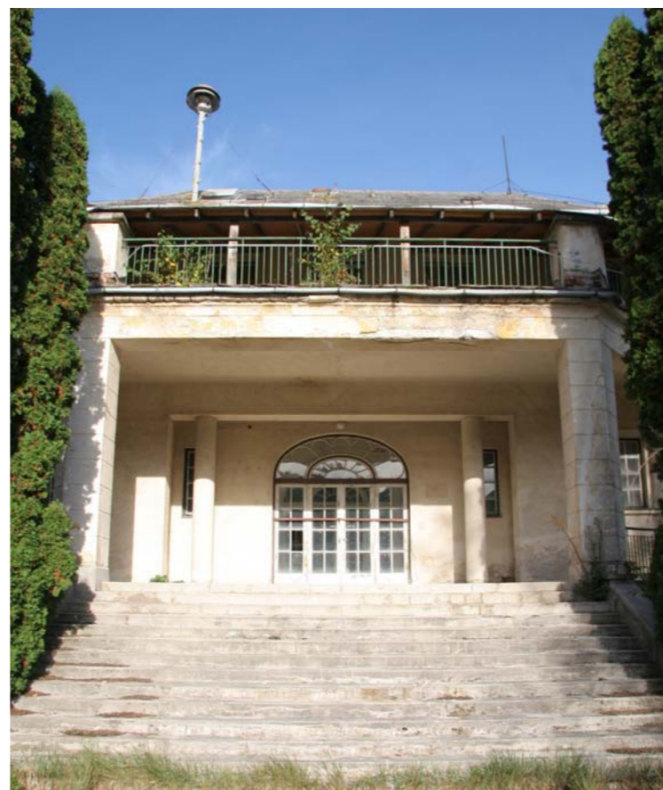
Az épület jelenlegi állapota
